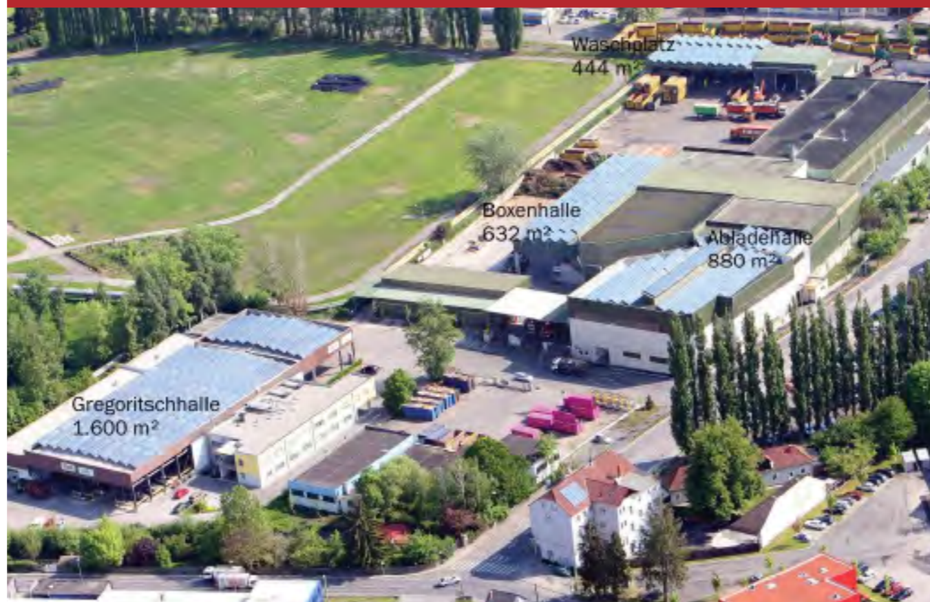
FIGURE 96: ABFALL-ENTSORGUNGS-UND VERWERTUNGS (AEVG) WASTE COLLECTION SITE SOLAR THERMAL PLANTS, GRAZ, AUSTRIA SOURCE: SOLAR THERMAL WORLD
